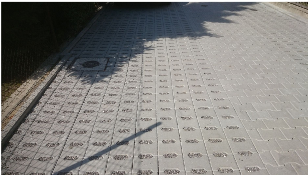
Sposób ułożenia kostki betonowej na ulicy Purpurowej w celu retencji wód opadowych.
